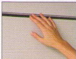
Le système protège-doigts breveté évite aux doigts de se faire écraser, de l'intérieur ou de l'extérieur de la porte.
