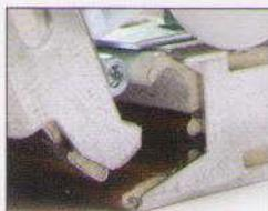
Les joints de sections procurent une double action d'étanchéité réduisant l'infiltration d'air.
